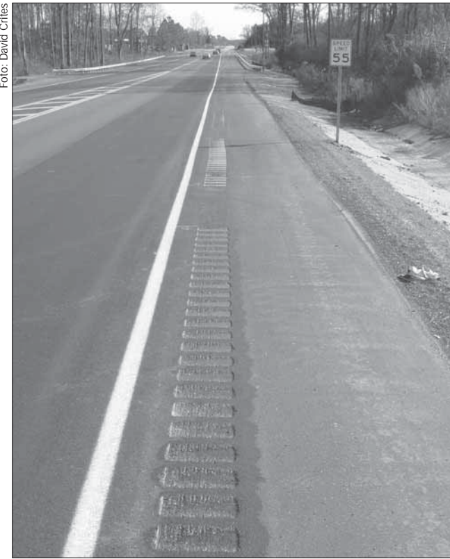
Las franjas retumbantes de arcenes más modernas incluyen espacios que permiten que los ciclistas entren y salgan del arcén pavimentado.
