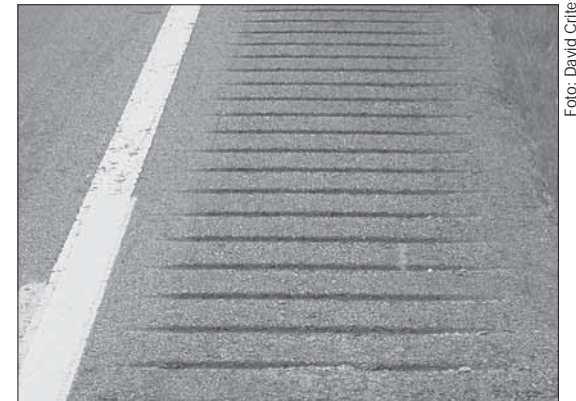
Las franjas retumbantes de arcenes más antiguas ocupan los 4 pies (1,2 m) de arcén pavimentado
